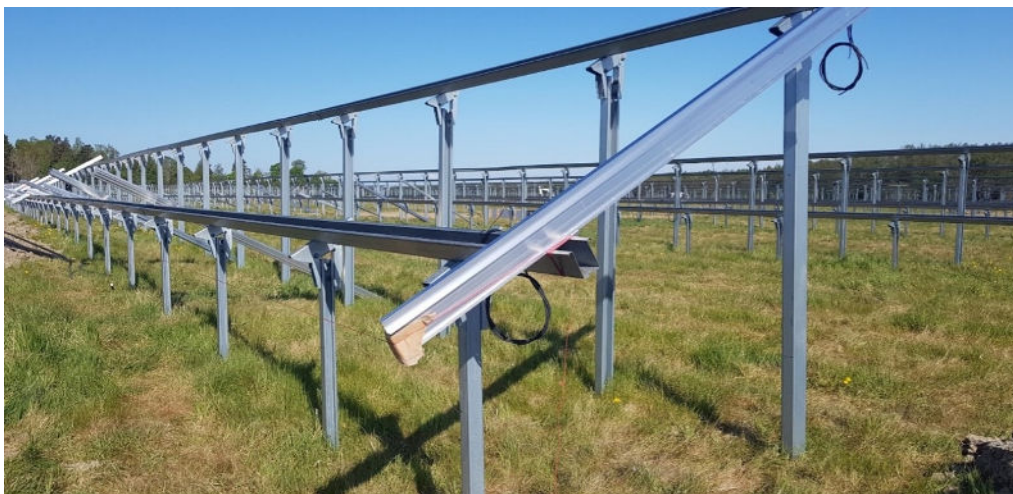
Figur 5. Bild på montagesystemet för sydsystem (Solkompaniet, 2024).
