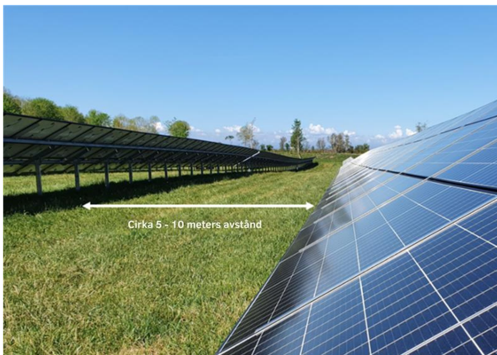
Figur 7. Illustrerar ungefärligt avstånd mellan panelraderna. För solparken kommer minst 5–10 meter radavstånd att hållas (Solkompaniet, 2024).
