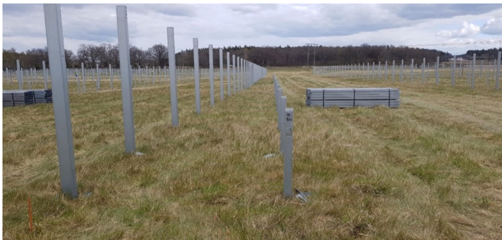
Figur 5. Bild på pålade markstolpar (Solkompaniet, 2024).
