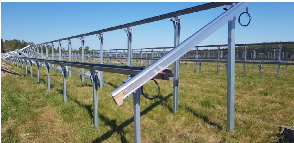
Figur 6. Bild på montagesystemet för sydsystem (Solkompaniet, 2024).
