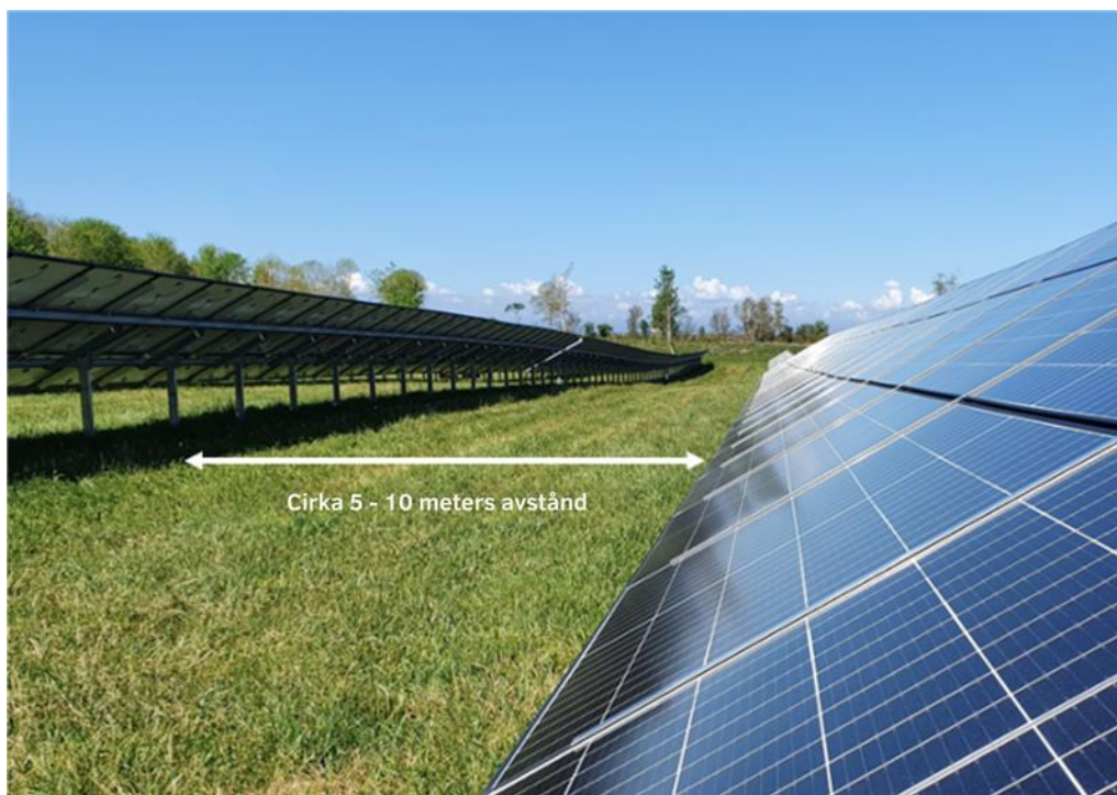
Figur 8. Illustrerar ungefärligt avstånd mellan panelraderna. För solparken kommer minst 5–10 meter radavstånd att hållas (Solkompaniet, 2024).
